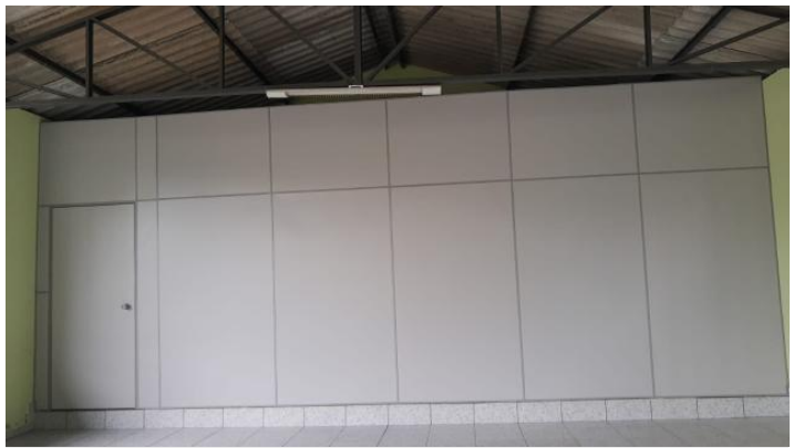
MELHORIAS NA UNIDADE - DIVISÓRIA NO GALPÃO
