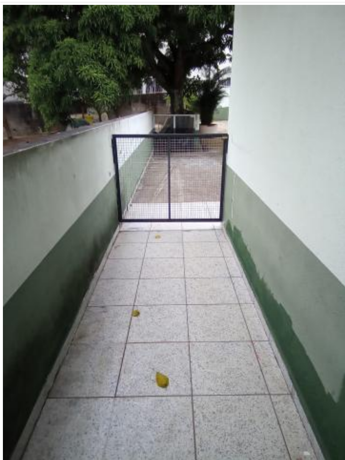
MELHORIAS NA UNIDADE - PORTÃO LATERAL DO CORREDOR
