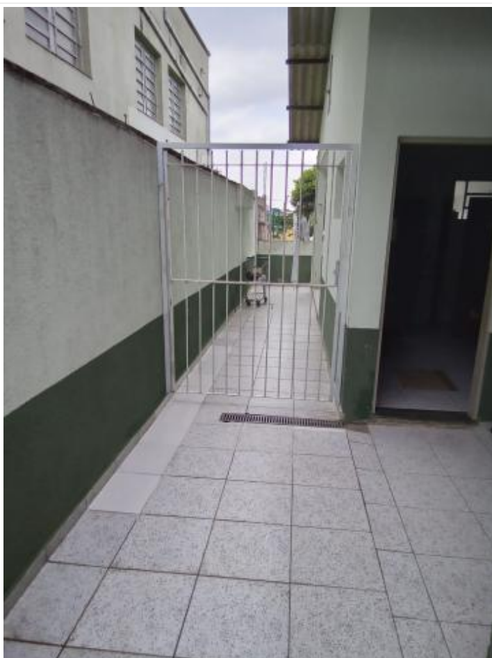
MELHORIAS NA UNIDADE - PORTÃO DA LAVANDERIA
